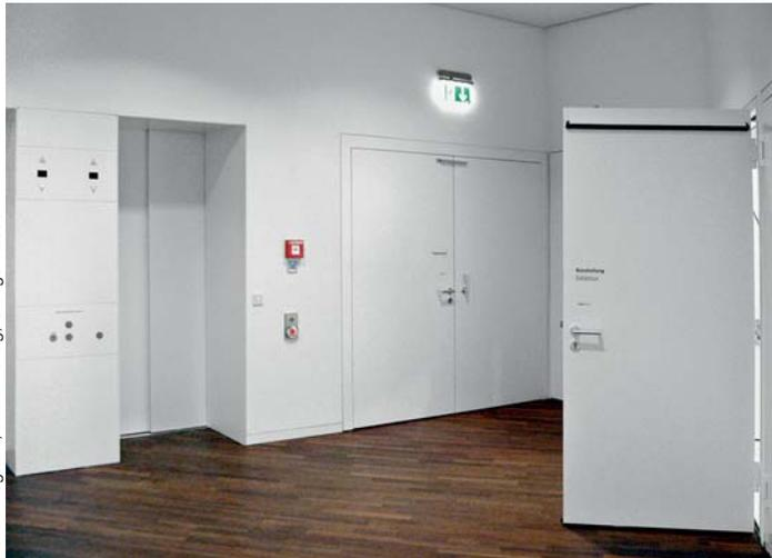
Oben: Den Übergang zum Restaurant „Christophorus“ und Konferenzbereich bilden weiße T30/RS Türen mit Kabelkanälen für die Elektrik sowie Magnet-, Riegel- und Schaltkontakten. Sie bieten Sicherheit in jeder Hinsicht.
