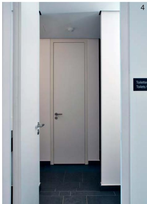
**1** Systemtrennwände mit Schallschutztüren SD 45 dB Rw,P. **2** T90 Tür, einflügelig, Typ 8, mit ITS. **3/4** T30 Nassraumtüren mit PU-Kante.
