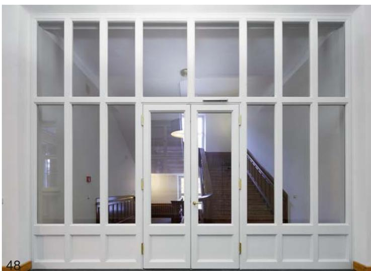
Links: T30/RS Anlage mit einer zweiflügeligen T30/RS Tür, Typ 27 N, in einer F30 Verglasung, Typ 25 V. Unten: F90 Verglasungen als Bogenelemente, wandbündig in den Treppenhäusern.
