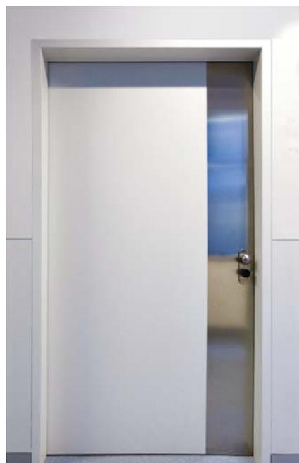
Detail Patientenzimmertüren SD 37, Typ 3 N, mit Edelstahl-schutzkante 3-flächig umfassend, flächenbündig eingefräst.
