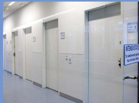
T90/T30 Brand-, Rauch-, Schall- und Strahlenschutztüren, T30 Nassraumtüren, T30 Holzschiebetüren, teilweise in Überbreite, größtenteils mit senkrecht verlaufendem Edelstahlblech, Oberfläche aus hoch beanspruchbarem Schichtstoff.
