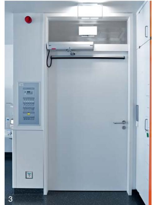
**1** Die helle, transparente Glasarchitektur gibt dem Zweckbau eine freundliche und offene Atmosphäre. **2** T90/RS Tür, Typ 8.10, mit Lichtausschnitt und Gleitschienenschließer. **3** T30/RS Türanlage in Stahlzarge mit F30 Oberlicht, Steuerung mit automatischem Drehflügelantrieb. **4** Schallschutztür SD 42 in Überbreite, PU-Kante, Schichtstoff, Stahlzarge.
