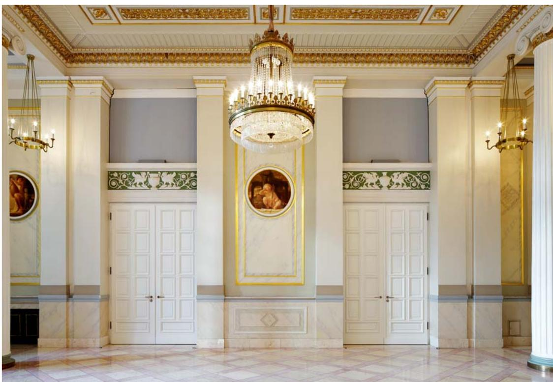
Entsprechend den historischen Vorbildern entwickelte Schörghuber Türen, die dem heutigen Stand der Technik und den aktuellen Anforderungen entsprechen. Dazu gehören die T30/RS Türen mit ITS-Schließern und Vollpanikfunktion, Oberfläche in RAL-Lackierung 9010 mit Rahmen- und Feldaufdoppelung.
