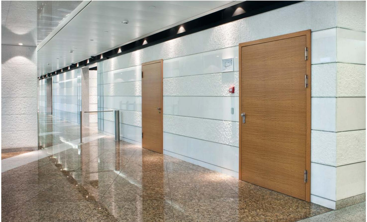
Oben: EI60 Türen mit horizontal verlaufendem Furnier und integriertem Türschließer.
