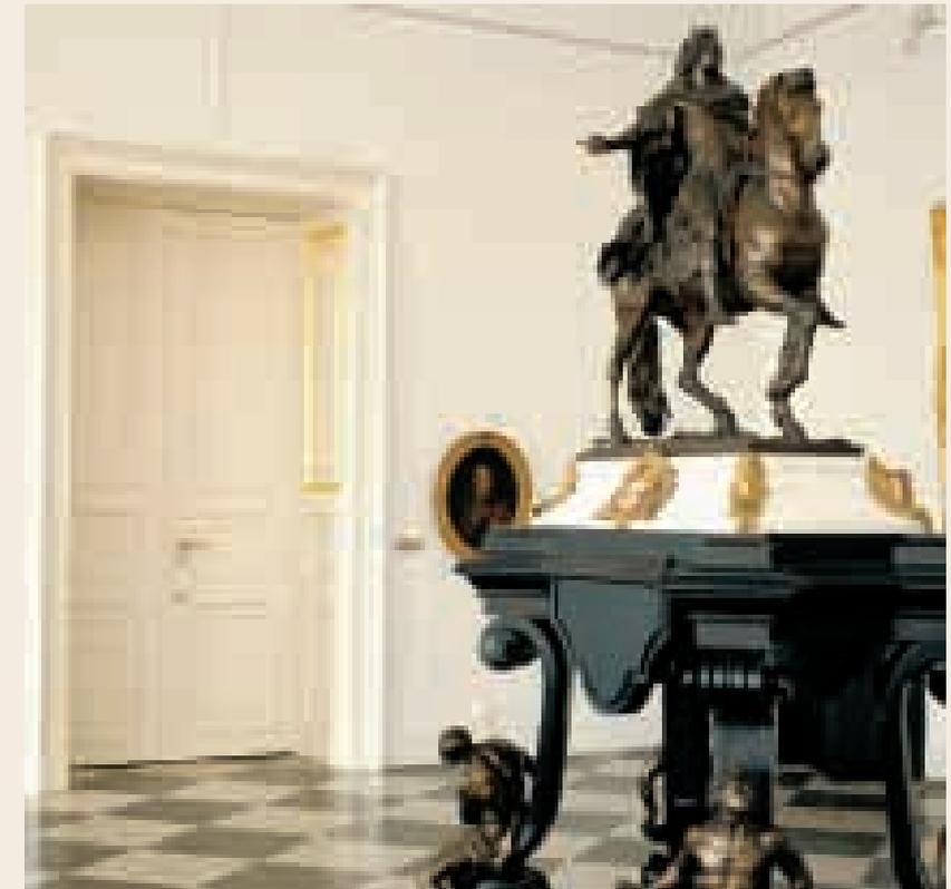
**T60-Brandschutztür in Sonderhöhe von 3,45 m, mit zum Teil bereits vergoldeten Profilen.**
