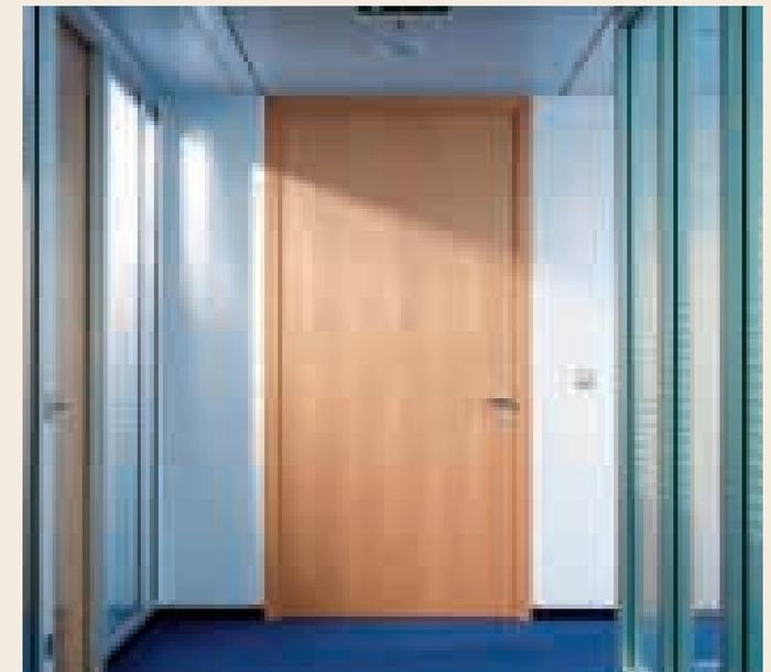
Den Zugang zur Schleuse in den Etagen kennzeichnet eine Rauchschutztür vor dem eigentlichen Brandschutzabschnitt.
