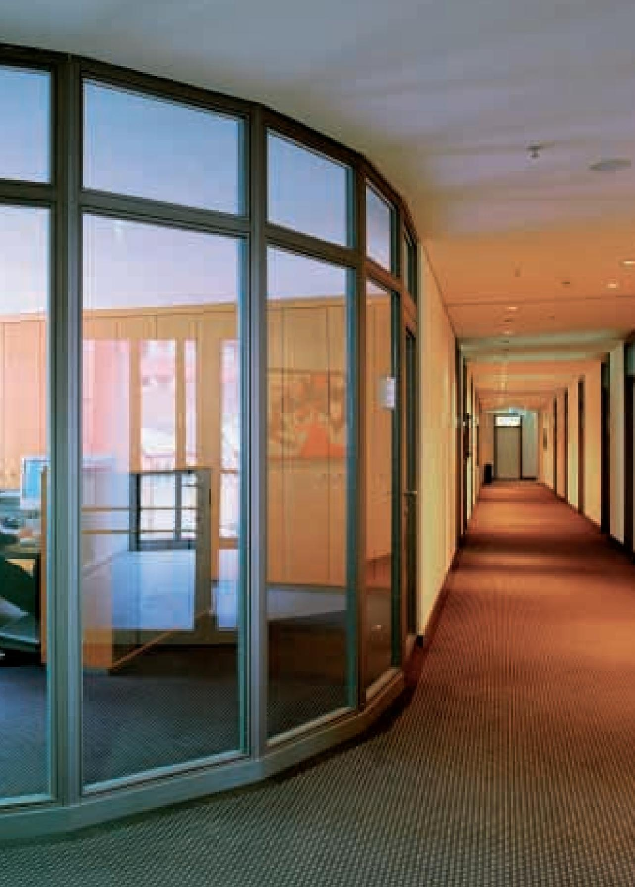
Um die Flure zu erhellen, wurden die Sekretariate mit F30-Verglasungen ausgestattet. Für einen besonderen Effekt sorgt die Metallic-Speziallackierung der Holzprofile.
