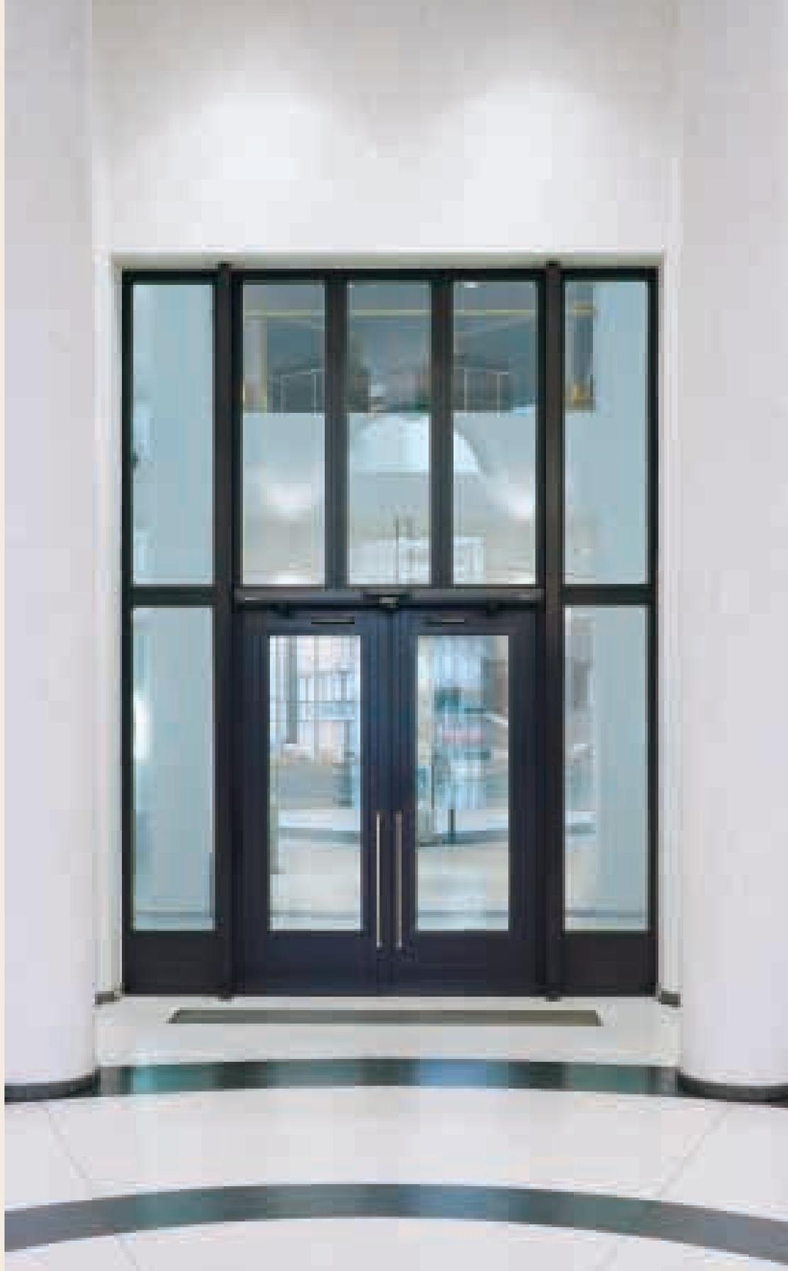
Brandtechnische Abschottung des großzügigen Zugangsbereichs zwischen SB-Zone und Schalterhalle mit T30-Türelement und F30-Festverglasung. Nach Schalterschluss wird das Glas „opak“ und verwehrt den Durchblick.
