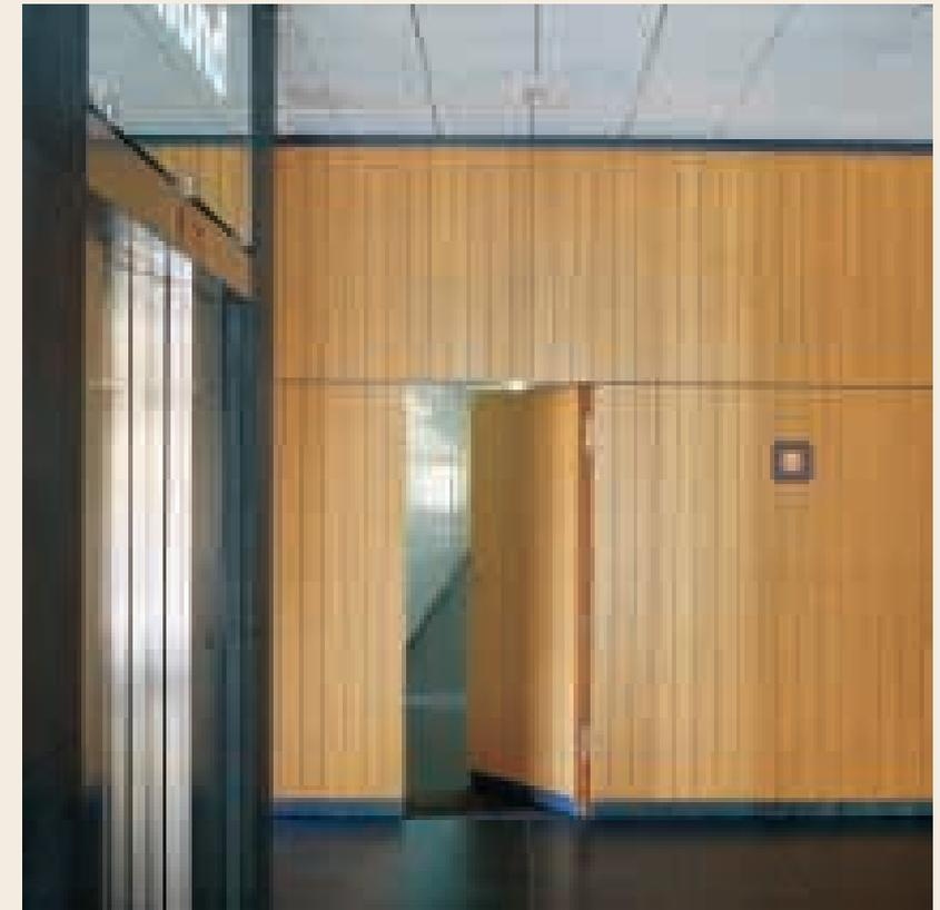
Mit speziellen Zargenvarianten können Funktionstüren elegant in Wandverkleidungen integriert werden.
