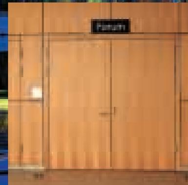
In den enormen Abmessungen der Spezialtüren (Brand-, Rauch- und Schallschutzfunktion) spiegeln sich die Dimensionen der gesamten Anlage wider.
